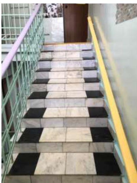
Лестница (на 2 этаж) – фото 10
