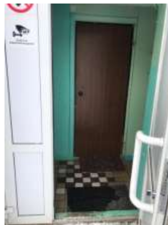
Дверь (входная) и тамбур центральный вход – фото 4
