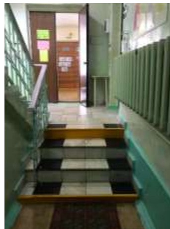
Лестница (от входа) – фото 7
