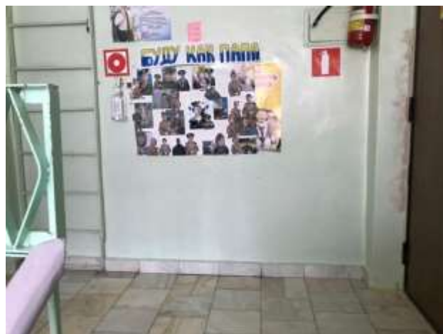
Лестница (площадка 2 этажа) – фото 11
