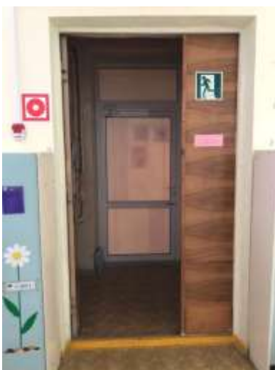
Дверь (входная) и тамбур запасный выход – фото 5
