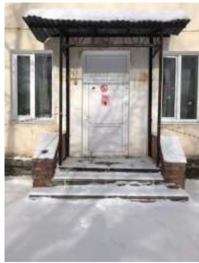
Лестница (наружная) и входная площадка запасный выход – фото 2
